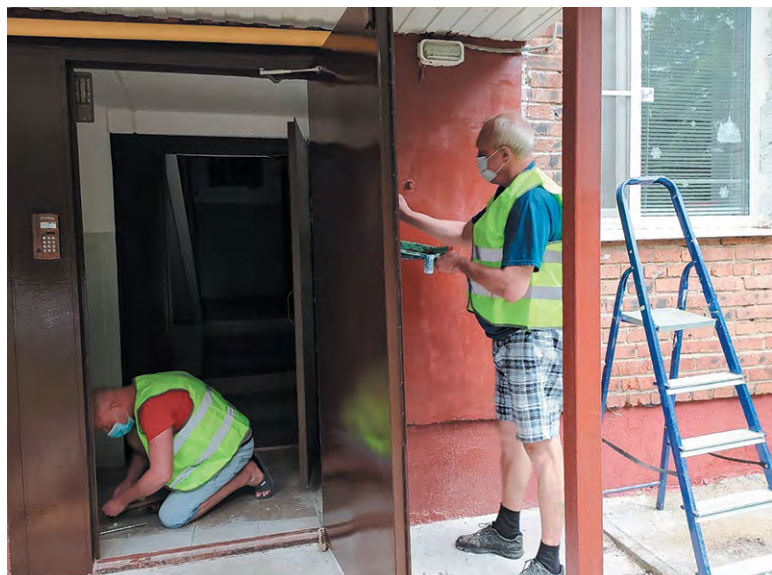
Подрядчики приводят в порядок входные группы многоквартирных домов
