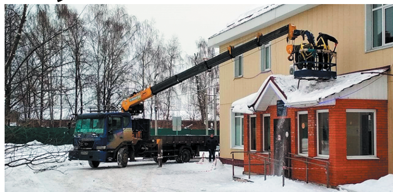
Очистка скатных кровель – работа трудоёмкая, но необходимая
