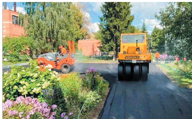
На территории поселения продолжается дорожное строительство
